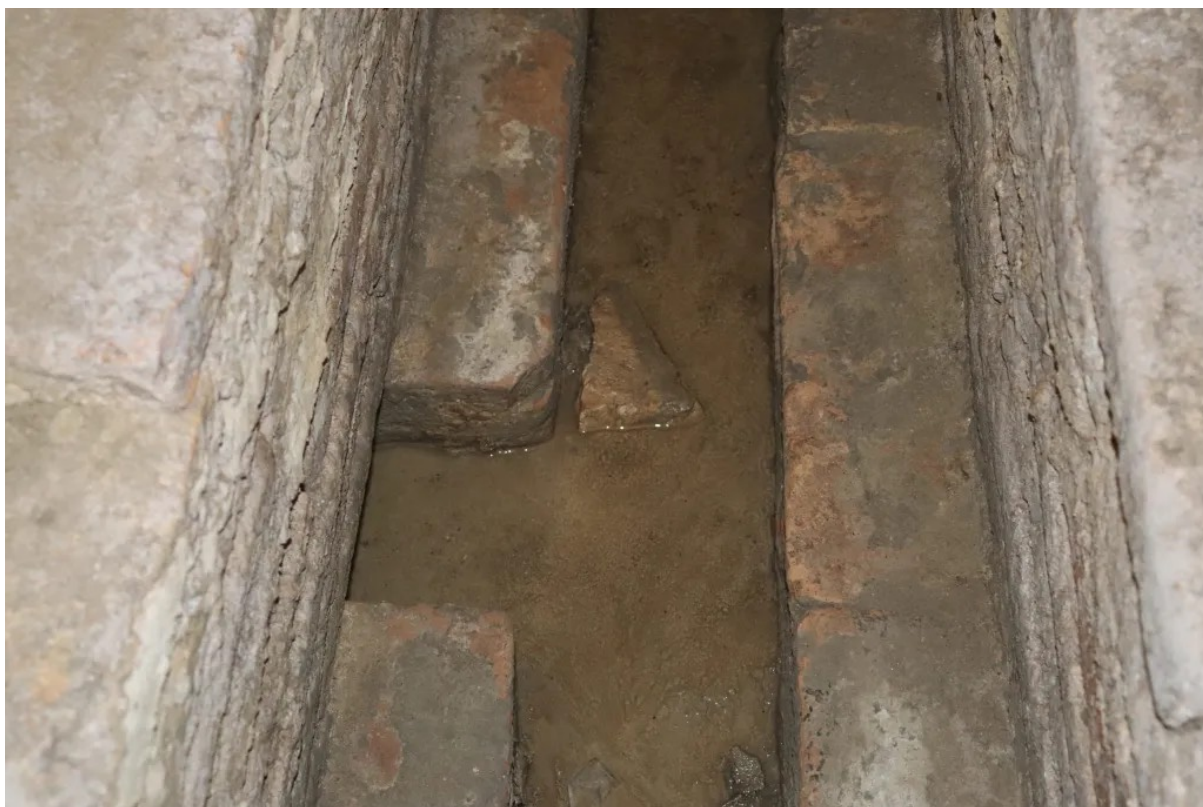
Cunicolo romano - foto scorrimento acqua e appoggi per l'ispezione - foto di Virginia Recanati - oggi diritto riservato-
